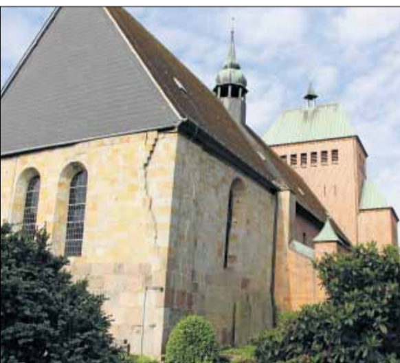
Gildehauser Sandstein ist der Grundstoff der St.-Johannes-Kirche von Wietmarschen. 1927 wurde das Gotteshaus wesentlich erweitert.
